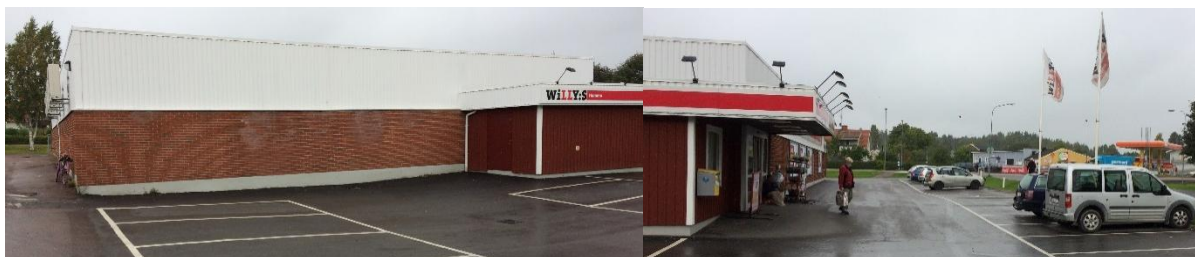
Befintlig bebyggelse på fastigheten Liljan 3.
