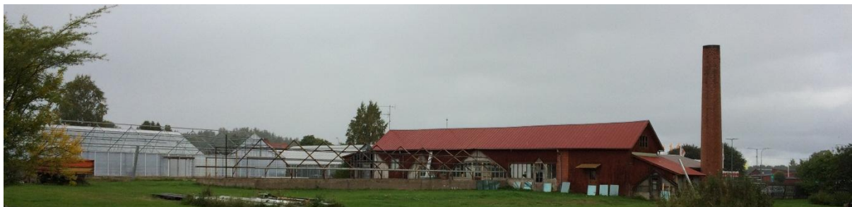
Befintlig bebyggelse på fastigheten Liljan 4.
