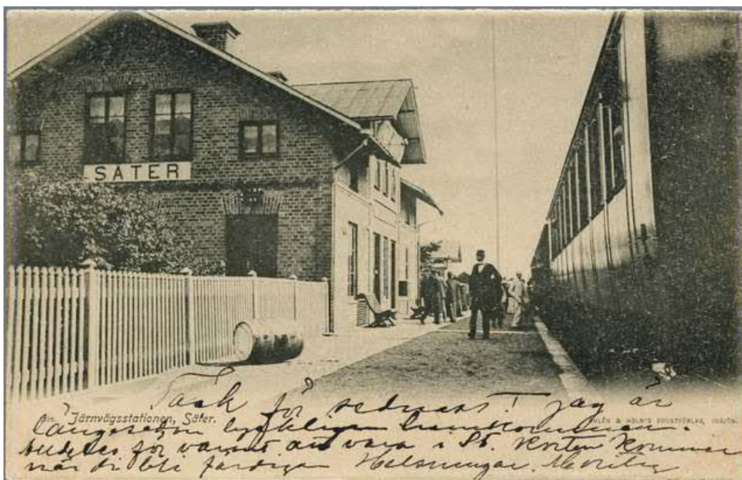
Bild från förra sekelskiftet som visar Sätters station från norr. Lägg märke till att stationsbyggnaden till skillnad från idag var oputsad. Många fönster är också bytta, men i stora drag är byggnaden sig lik. Det plåttak som täcker byggnaden är sannolikt ursprunglig. Då det har plåtmått och läggning typisk för 1800-talet. Tänk också på det kontursågade spjälstaket och stolparna med krön.
