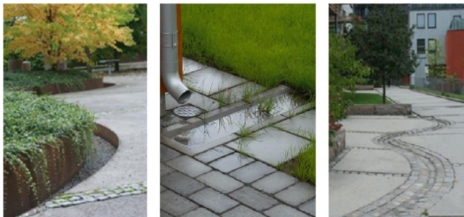
Figur 19. Exempel på utformning av dagvattenrännor i urban miljö. (Det högra och vänstra exemplet är foton från Sweco, exemplet i mitten kommer från S:t Eriks rännalsplattor).
